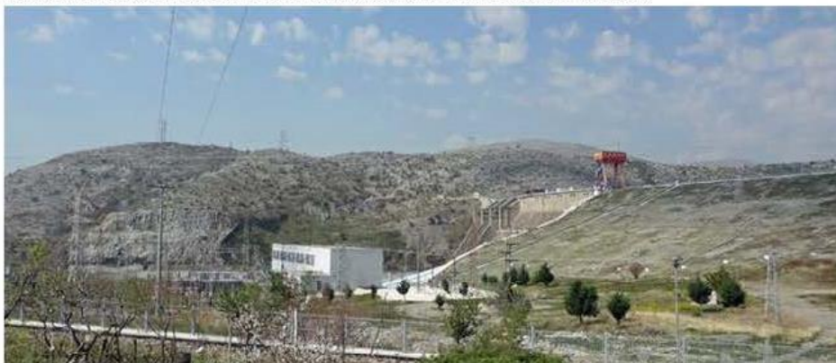
Figura 8: Diga e Vaut të Dejës turbina edhe nën-stacioni elektrik
